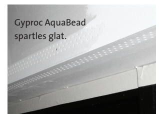
Vand sprayeres på Gyproc AquaBead.
