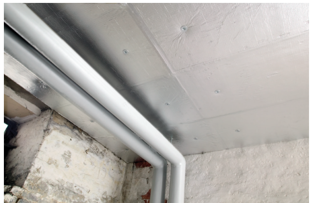
Med ISOVER Duo bliver kælderen lysere. Isoleringen absorberer lyden og sikrer en effektiv isolering i forhold til de varmere rum ovenover.
