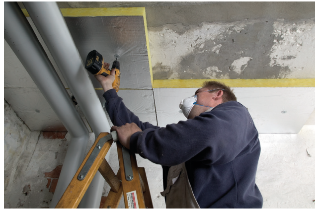
Pladerne monteres direkte i betonen ved hjælp af to specialskruer, som ikke kræver rawlplugs.
