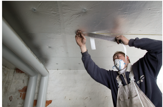
ISOVER Duo pladerne tapes sammen med ISOVER Duo-Tape, så overfladen bliver helt ensartet.
