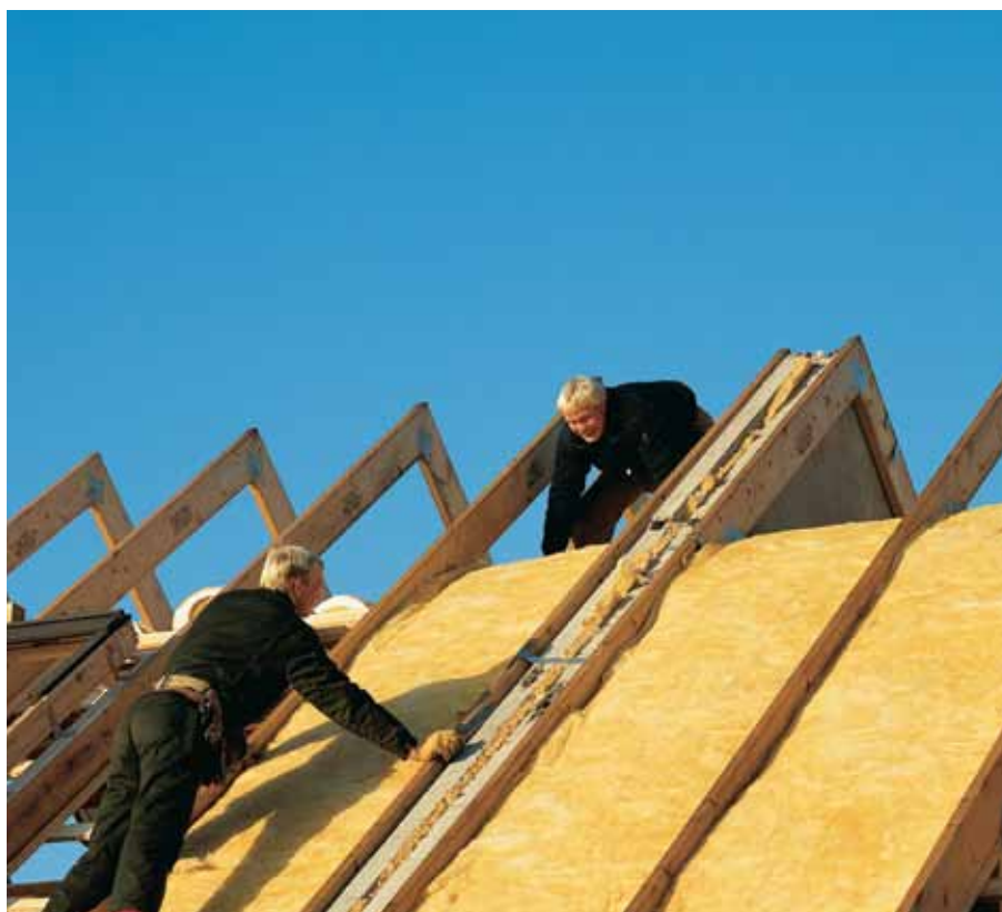
Fig. 310.59. Isolering af tagkonstruktion.
