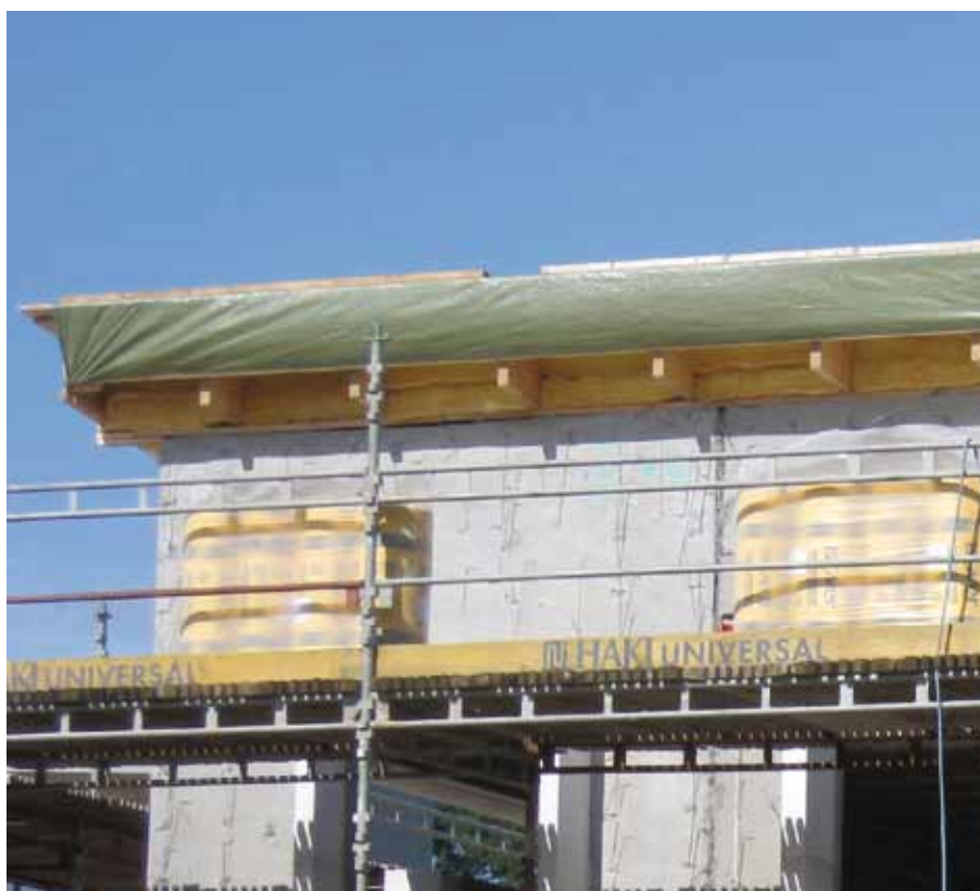
Fig. 310.60. Isolering af tagkonstruktion.
