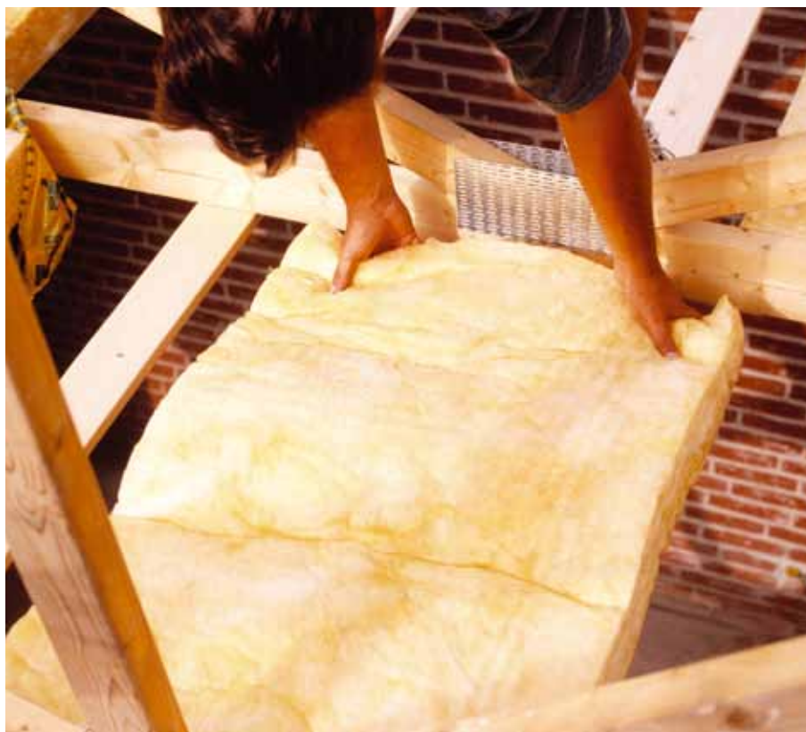
Fig. 310.58. Isolering af tagkonstruktion.
