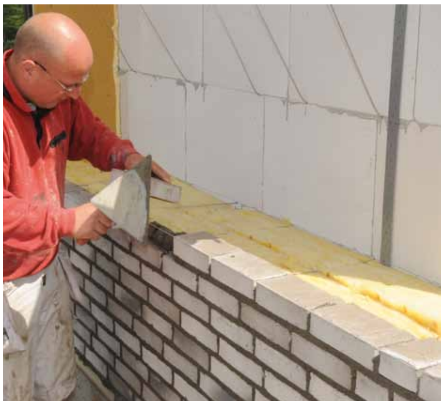
Fig. 410.67. Isolering af hulmur.
