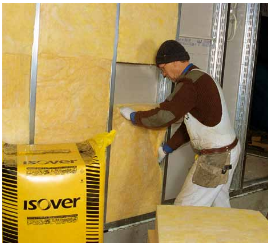
Fig. 410.69. Isolering af stålskelet.
