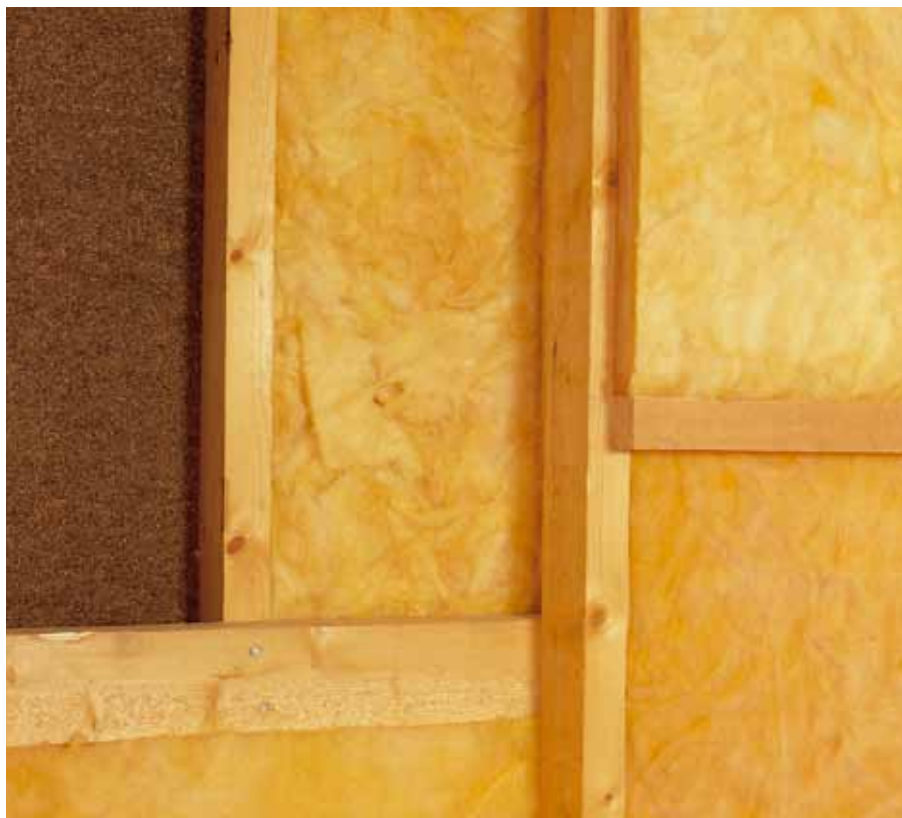
Fig. 410.68. Isolering af træskelet.
