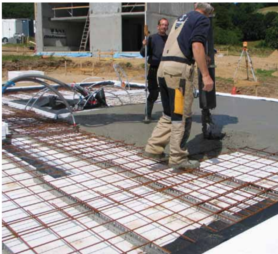
Fig. 610.42. Støbning af terrændæk.
