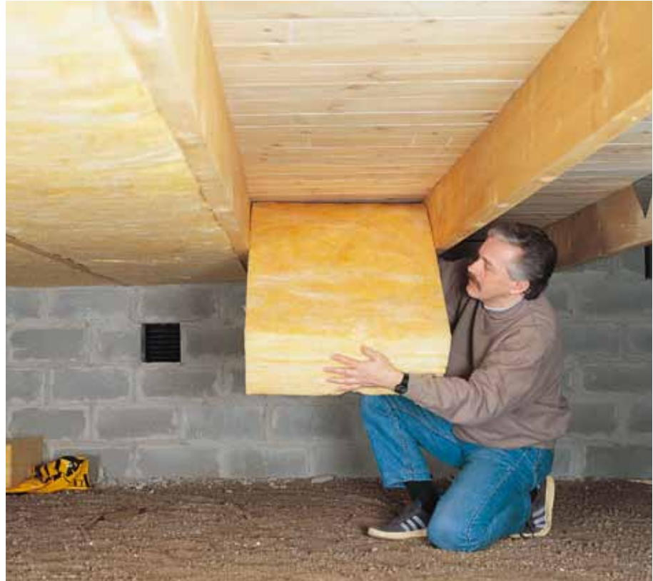
Fig. 610.45. Isolering af krybekælderdek.
