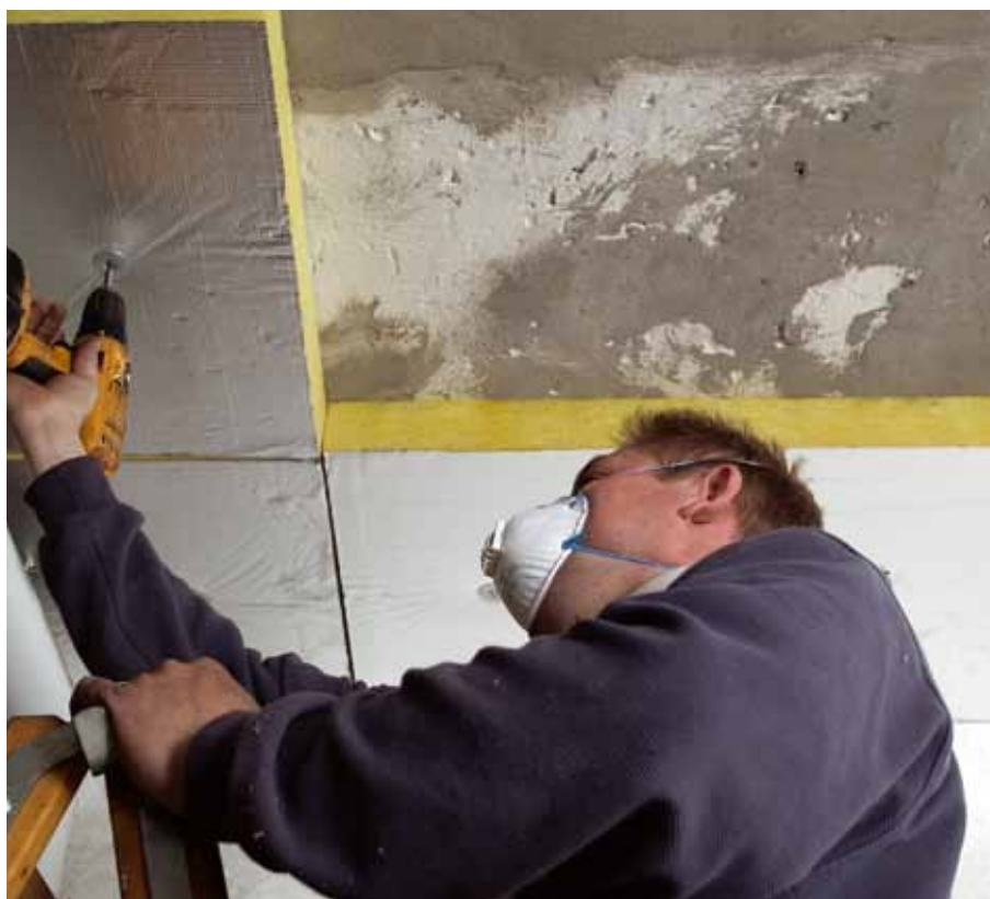
Fig. 610.46. Isolering af dæk med ISOVER Duo
